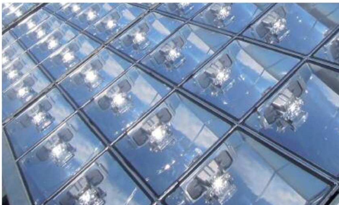
▼ Particolare del nuovo impianto fotovoltaico a concentrazione (CPV), capace di produrre più energia rispetto a quello tradizionale al silicio.
